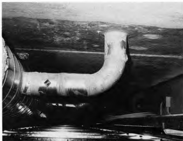
Fig. 1 Luchttoevoer naar de geprefabriceerde holle vloerplaat.
