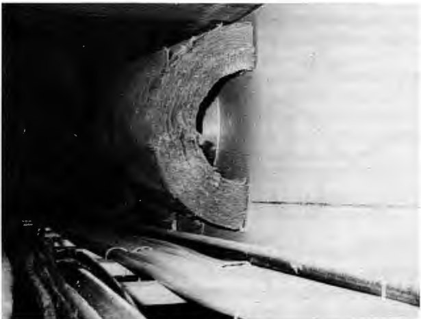
Fig. 5 Luchtafvoer vanuit het vertrek naar de gang, gezien vanuit de gang.
