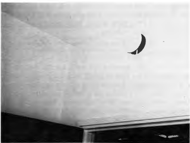
Fig. 4 Luchtafvoer naar de gang (overstort), gezien vanuit het vertrek.
