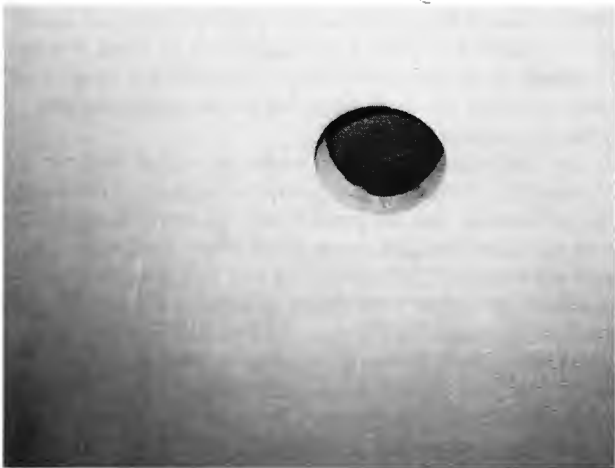
Fig. 3 Luchtuitblaasgat in de vloerplaat.
